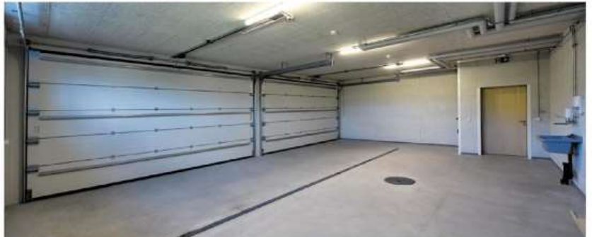
Für die «Stügg»-Busse entstand eine Garage. Damit müssen sie im Winter nicht mehr von Schnee befreit werden. (Bilder: Hans Ulrich Gantenbein)
