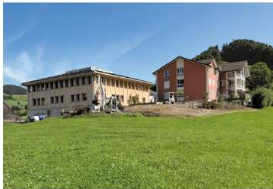
Das neue Werkstattgebäude wurde neben dem 2005 eingeweihten Wohnheim realisiert. (Bild:HY)
